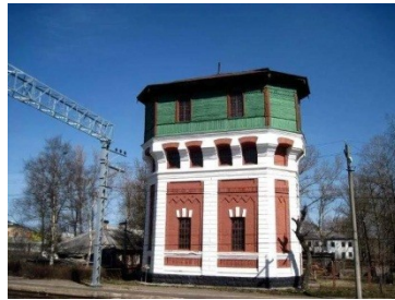
Водонапорная башня на железнодорожном вокзале
